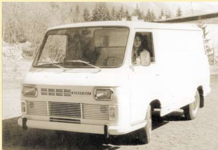
Опытный образец Skoda 778 построили в 1972 году как вариант модернизации семейства 1203. Автомобиль оснащался 1,5-литровым мотором.
